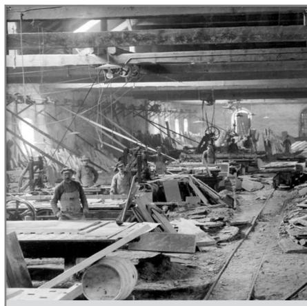
Plattenfabrik um 1920 mit Säge- und Hobelmaschinen
